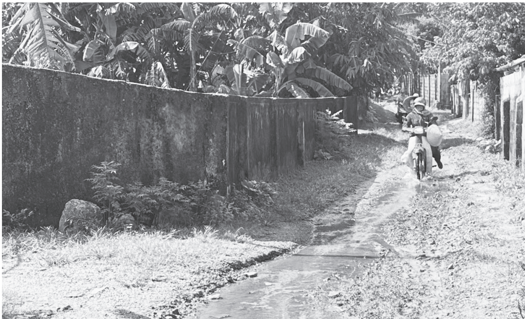
Sau khi người dân phản ánh về sự xuống cấp của tuyến đường ở thôn Xuân Hòa, xã Lệ Ninh, địa phương đã lập dự án đầu tư bê tông hóa với kinh phí 1,5 tỉ đồng - Ảnh: L.C
