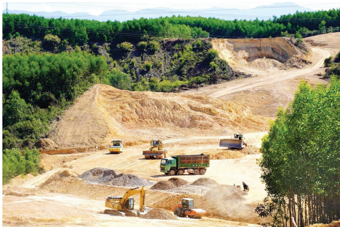
Thi công các công trình, dự án đang bước vào giai đoạn tăng tốc đòi hỏi nguồn vật liệu cần được cung ứng kịp thời
