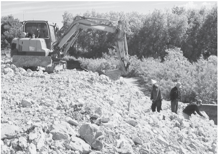
Phường Đồng Sơn sửa chữa, gia cố đập Rẫy Hò trước mùa mưa lũ - Ảnh: B.N
