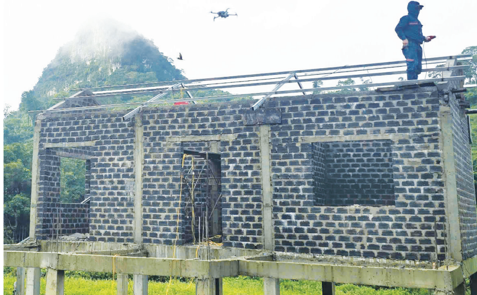
42 căn nhà kiên cố bằng bê tông, tường gạch, mái lợp tôn do UBND TP. Hồ Chí Minh tặng đồng bào A Rem đang được khẩn trương hoàn thiện - Ảnh: P.P
