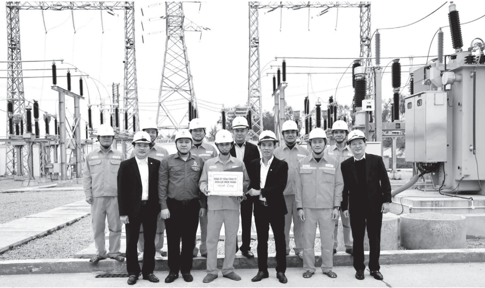
Một công trình điện tại khu vực phía Bắc của tỉnh được đưa vào vận hành, sử dụng - Ảnh: M.NG
