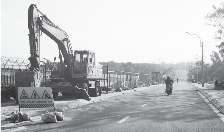
Gấp rút thi công các công trình xây dựng cơ bản trước mùa mưa lũ
