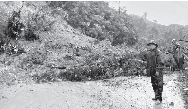
Quốc lộ 15D sạt lở, đất đá tràn xuống mặt đường gây ách tắc - Ảnh: UBND XÃ LA LAY CUNG CẤP
