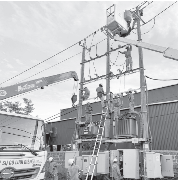
Một công trình sửa chữa lớn được Điện lực Quảng Ninh thực hiện trong năm 2026 - Ảnh: V.M
