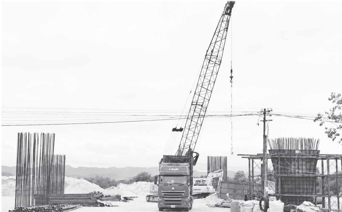
Thi công cầu vượt đường sắt và Quốc lộ 1 của Dự án đầu tư xây dựng Quốc lộ 15D
