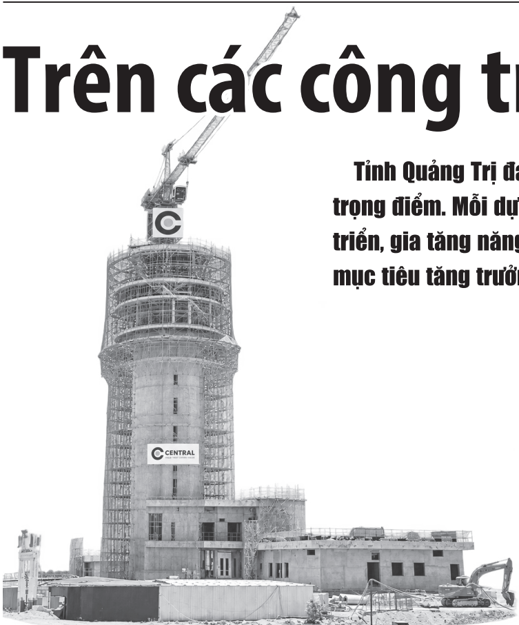
Đài Kiểm soát không lưu Dự án Cảng hàng không Quảng Trị hoàn thành cất nóc, chuyển sang lắp đặt các hệ thống thiết bị chuyên ngành - Ảnh: Q.H
