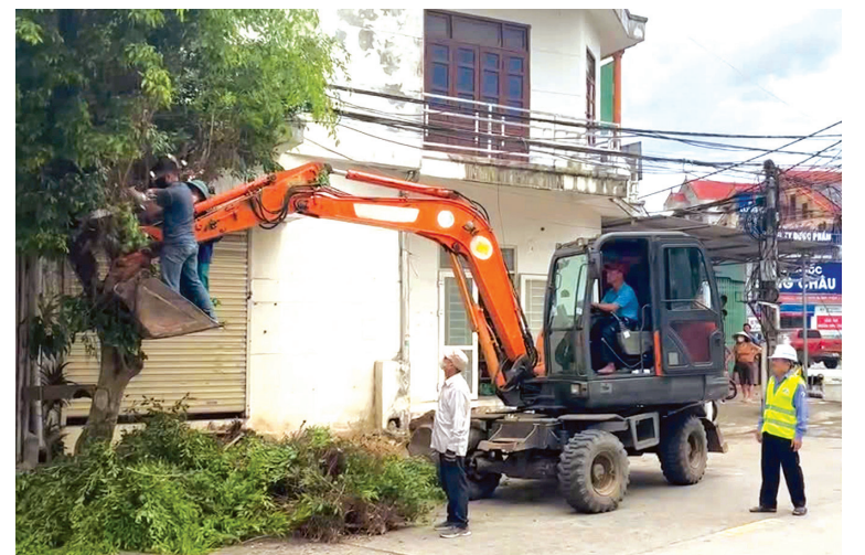
Xã Ninh Châu thực hiện giải tỏa, tháo dỡ công trình, vật kiến trúc vi phạm hành lang an toàn giao thông trên các tuyến đường - Ảnh: P.V
