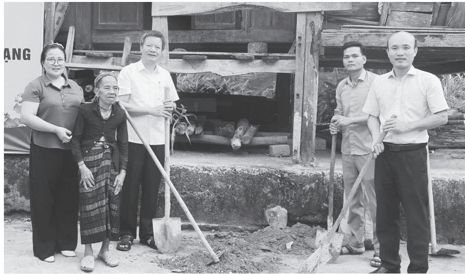
Khởi công xây dựng nhà mới cho bà Hồ Thị Bài, ở thôn Ruộng
