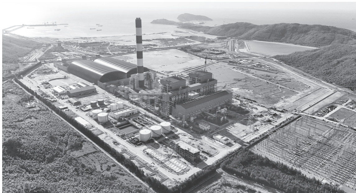
Nhà máy Nhiệt điện Quang Trạch I đang đẩy nhanh tiến độ để đưa vào vận hành thương mại - Ảnh: Q.V
