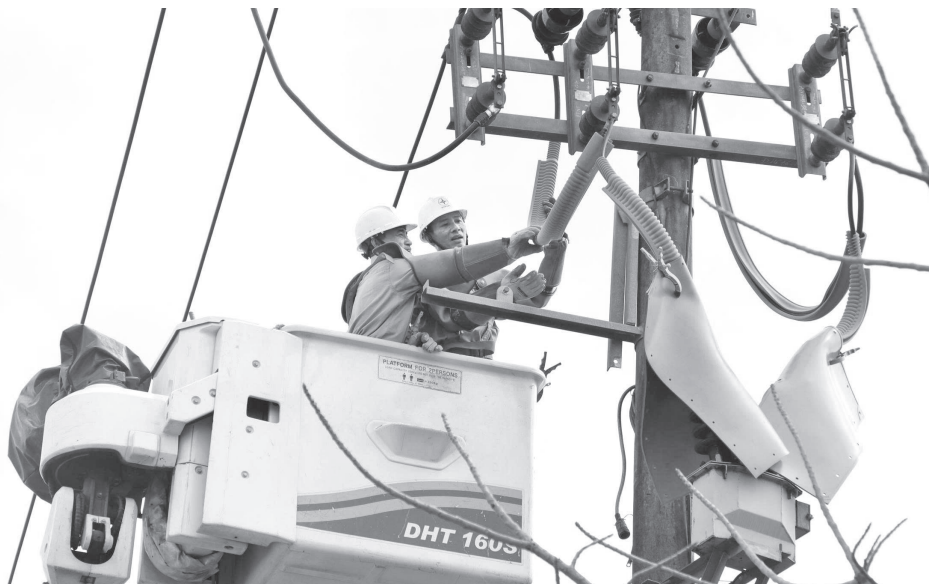
Công nhân hotline của PC Quảng Trị đang thực hiện sửa chữa điện nóng - Ảnh: M.N
