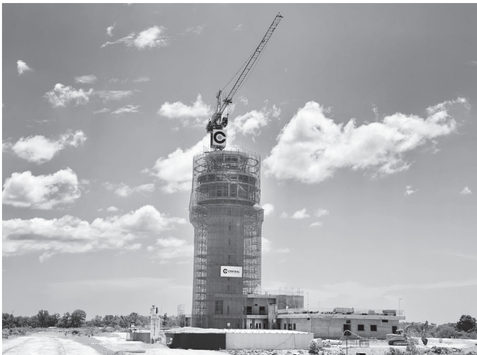
Đài Kiểm soát không lưu tại dự án Cảng hàng không Quảng Trị
