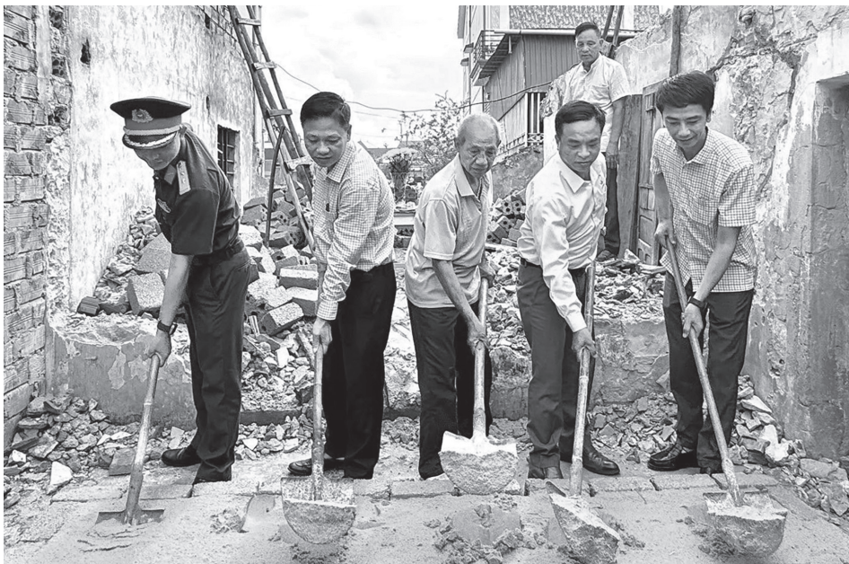
Lãnh đạo phường Bắc Gianh khởi công xây dựng nhà ở cho người có công - Ảnh: N.M
