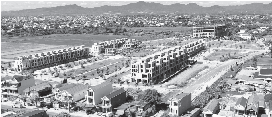
Khu nhà ở xã hội tại xã Lộc Ninh cũ đang dần hoàn thiện
