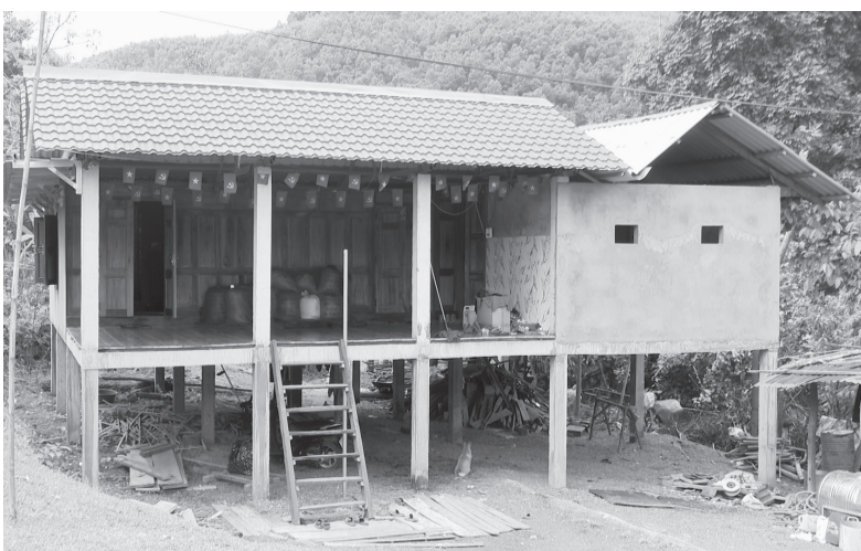
Căn nhà mới khang trang tại bản K-Vi được hoàn thành từ chương trình xóa nhà tạm
