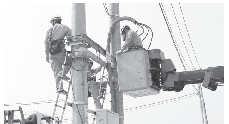
Công nhân Công ty Điện lực Quảng Trị chủ động khắc phục các sự cố để vận hành lưới điện ổn định, an toàn và liên tục - Ảnh: V.M
