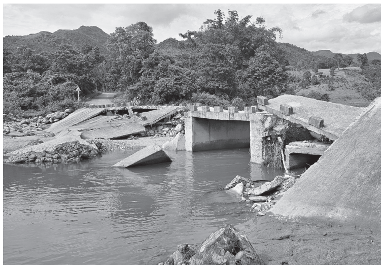
Mưa lớn gây hư hỏng tại cầu tràn xã Hướng Phùng, năm 2025
