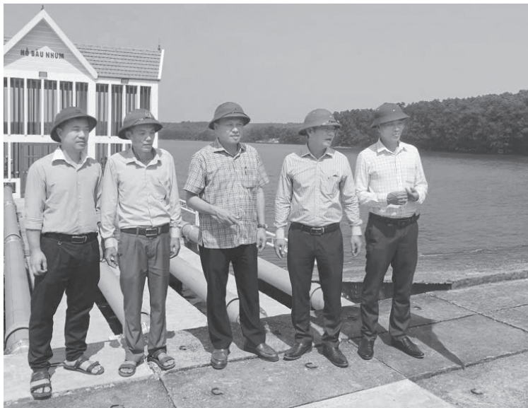
Chi cục Thủy lợi và Phòng chống thiên tai tỉnh phối hợp với các đơn vị, địa phương liên quan kiểm tra thực tế tại công trình thủy lợi Bàu Nhum - Ảnh: M.L
