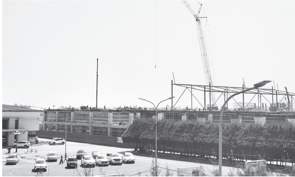
Các đơn vị thi công lắp cốt pha, thi công hệ thống cầu càn
