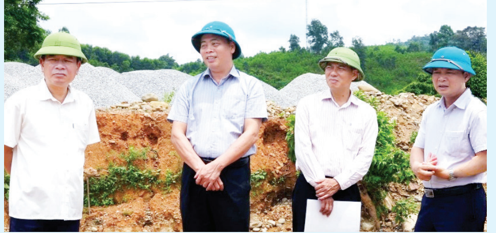
Đồng chí Nguyễn Đăng Quang, Phó Bí thư Tỉnh ủy, Chủ tịch HĐND tỉnh kiểm tra thực tế tại khu vực thi công đường nối đường Hồ Chí Minh nhánh Đông với nhánh Tây đoạn qua xã Vĩnh Ổ cũ (nay là xã Bến Quan) - Ảnh: M.N
