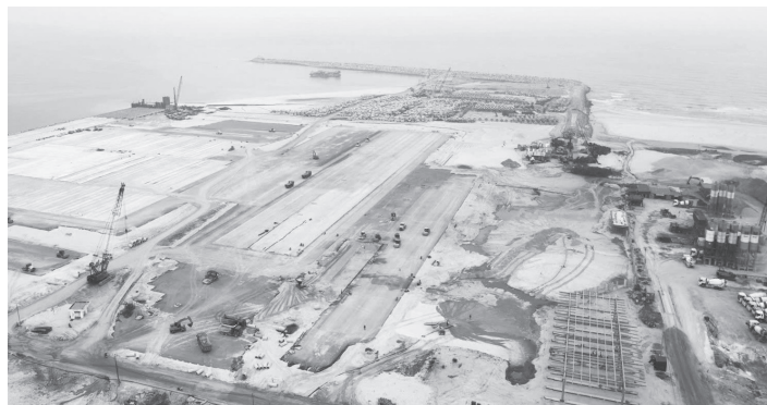
Hối hả trên công trường cảng Mỹ Thủy
