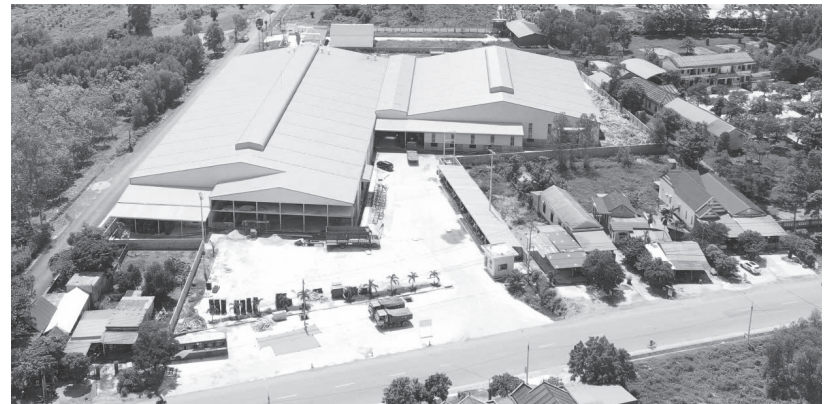
Cụm công nghiệp Cam Thành, xã Cam Lộ sẽ được mở rộng từ 25,5ha lên 30ha - Ảnh: L.T
