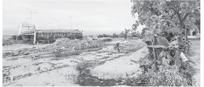
Đường dẫn vào đầu cầu phía Đông của cầu Nhật Lệ 3 chưa thể thi công do vướng giải phóng mặt bằng
