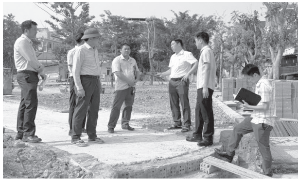
Lãnh đạo phường Đồng Hới kiểm tra tiến độ thi công công trình công viên đường Đại Phong - Ảnh: H.TR
