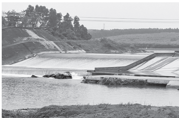
Đập tràn công trình Nam Thạch Hãn-nơi điều tiết nguồn nước đầu nguồn cho hệ thống thủy lợi - Ảnh: N.V
