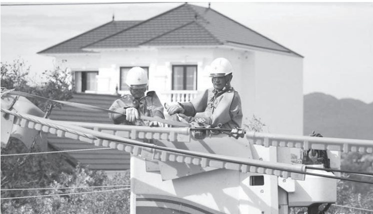
Đội sửa chữa nóng lưới điện PC Quảng Trị tuân thủ nghiêm ngặt quy trình kỹ thuật và các biện pháp an toàn điện - Ảnh: V.M
