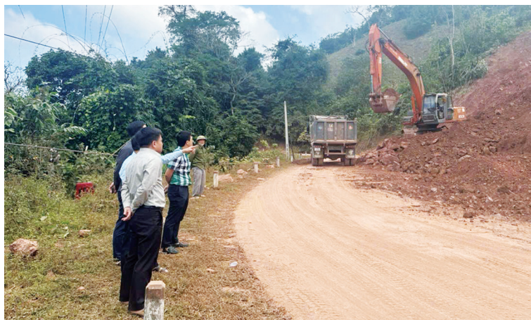
Đoàn kiểm tra do Sở Xây dựng chủ trì chỉ đạo đơn vị quản lý đường bộ sửa chữa đường bảo đảm an toàn giao thông thông suốt trên một tuyến đường - Ảnh: B.T
