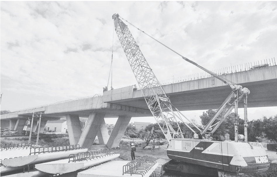
Gói thầu số 13 (xây lắp phần cầu) đang được liên danh các nhà thầu đẩy nhanh tiến độ thi công để hoàn thành - Ảnh: B.T
