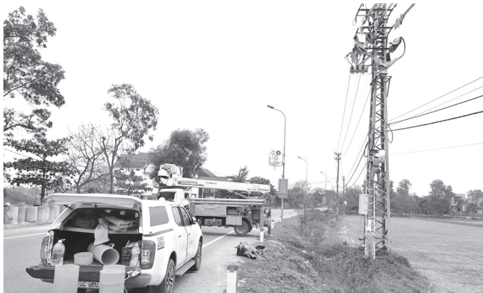
PC Quảng Trị thực hiện sửa chữa nóng trên lưới điện - Ảnh: V.M
