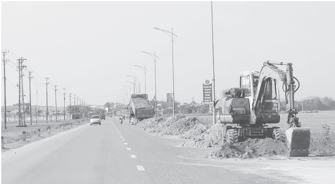
Các công trình, dự án giao thông chưa từng được thanh tra, kiểm tra, kiểm toán nhà nước nằm trong kế hoạch được tập trung thanh tra - Ảnh: B.T
