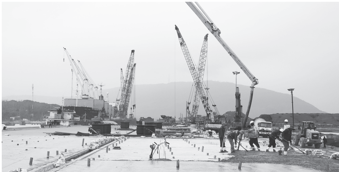
Các nhà thầu đang thi công Dự án Bến cảng tổng hợp quốc tế Hòn La
