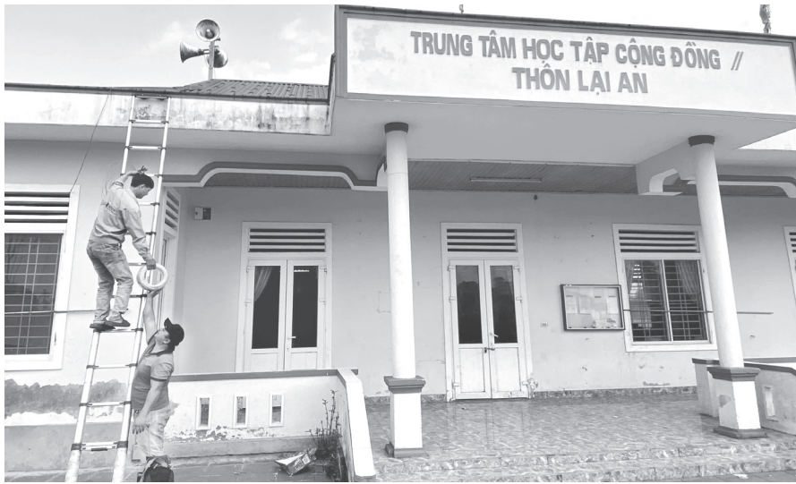
Triển khai lắp đặt bổ sung cụm loa truyền thanh tại thôn Lại An, xã Gio Linh để nâng cao chất lượng truyền thanh - Ảnh: Q.L
