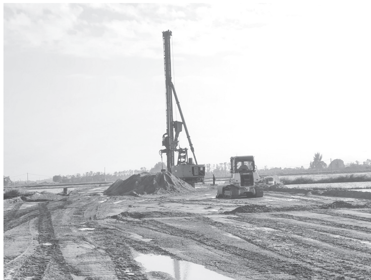
Nhà thầu đang thi công xử lý đất yếu, đắp cát thoát nước hạt trung tại địa phận phường Đồng Hới - Ảnh: B.T
