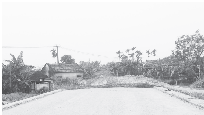
Một gói thầu phải tạm dừng thi công để chờ bàn giao mặt bằng - Ảnh: B.T
