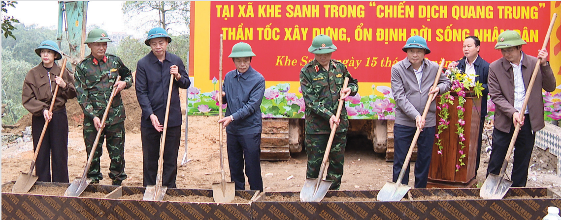
Các đồng chí lãnh đạo tỉnh, Quân khu 4 khởi công công trình kè chống sạt lở khu vực khu dân cư đường Hùng Vương, thôn 3A, xã Khe Sanh - Ảnh: PHƯỚC ĐẠT
