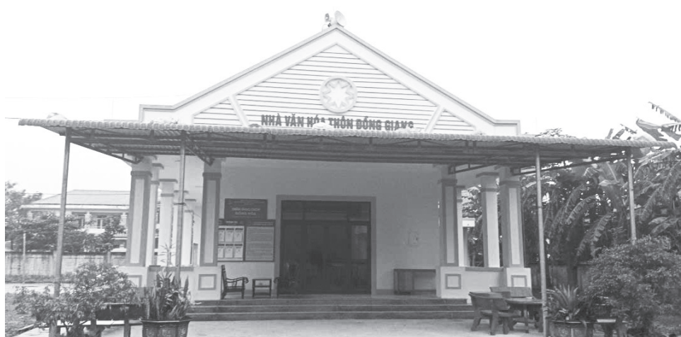
Nhà văn hóa thôn Đồng Giang được đầu tư xây mới khang trang và đưa vào sử dụng từ cuối năm 2024
