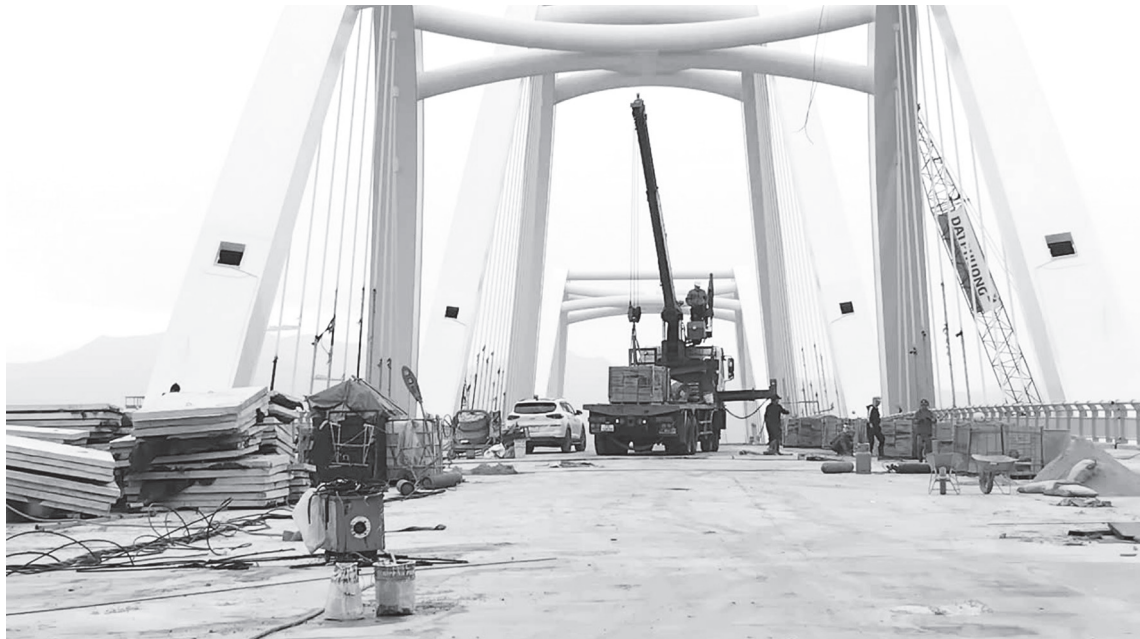
Phần công trình trên cầu Nhật Lệ 3 đang trong giai đoạn cơ bản hoàn thành
