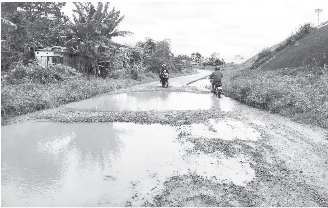
Người dân đi lại khó khăn, nguy hiểm vì đường dẫn từ đường Hoàng Diệu lên đầu cầu sông Hiếu thi công dang dở - Ảnh: H.N
