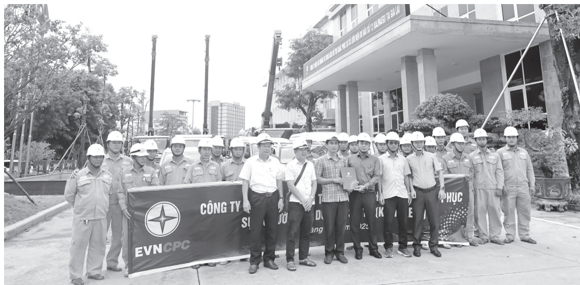
Công đoàn Công ty Điện lực Quảng Trị chi viện lực lượng, phương tiện hỗ trợ Công ty Điện lực Gia Lai khắc phục sự cố lưới điện do ảnh hưởng nặng nề của bão số 13 năm 2025 - Ảnh: V.M
