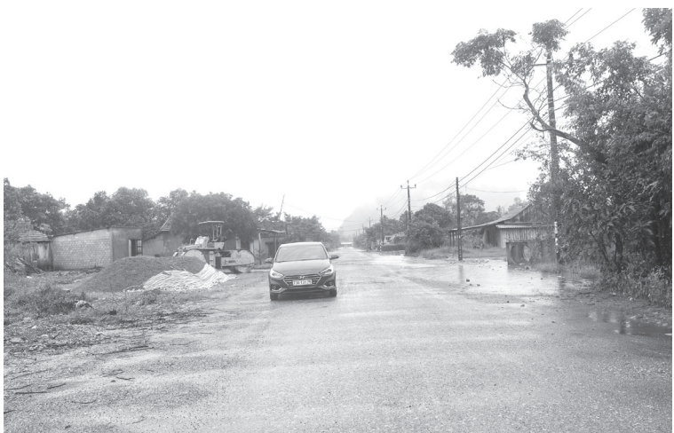
Tuyến đường giao thông nông thôn nối từ ngã ba Yên Hóa đi thôn Yên Bình đã hoàn thành trên 90% tiến độ
