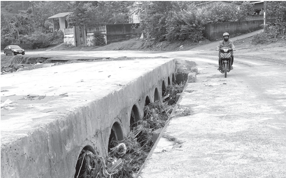
Cầu tạm cản trở dòng chảy đã làm ngập ngầm tràn thôn Ván Ri, xã Khe Sanh mỗi khi có mưa lớn - Ảnh: Đ.V
