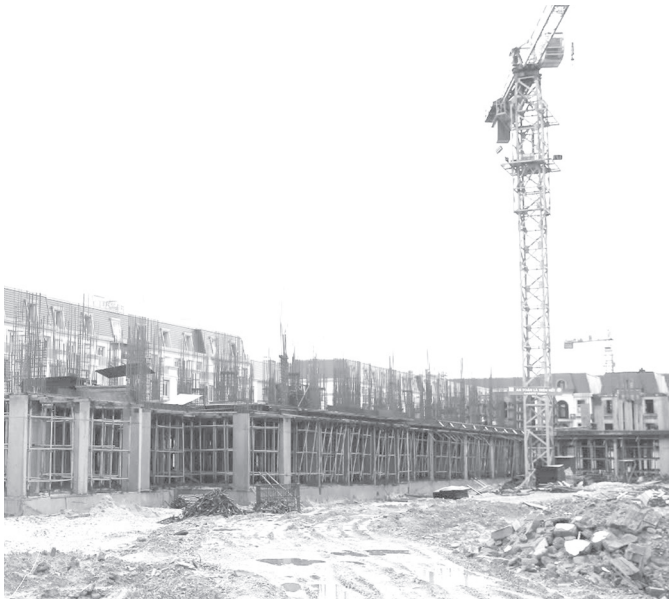
Dự án nhà ở xã hội Bảo Ninh 1 đang thi công tầng 1 - Ảnh: B.T
