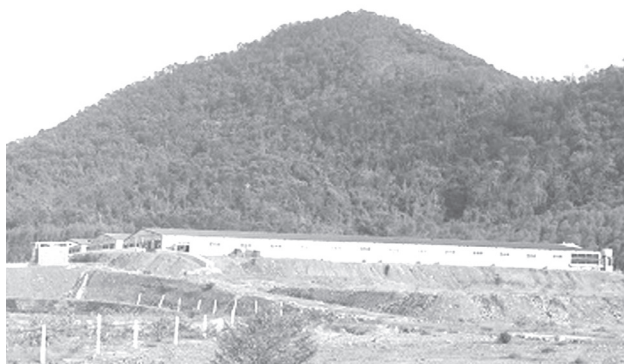
Sở Nông nghiệp và Môi trường yêu cầu Công ty TNHH chăn nuôi Bình Chi Nam Hưng dừng ngay các hoạt động chăn nuôi lợn tại trang trại - Ảnh: B.T
