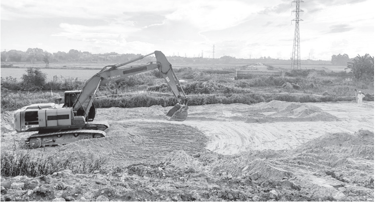
Ngay sau khi được UBND phường Đồng Sơn bàn giao mặt bằng, nhà thầu thi công đã triển khai thi công 3 ca
