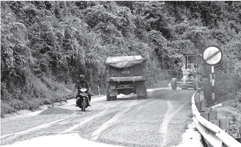
Đơn vị thi công đang tiến hành cải tạo, nâng cấp mặt đường tuyến Hồ Chí Minh (nhánh Tây) - Ảnh: Q.H
