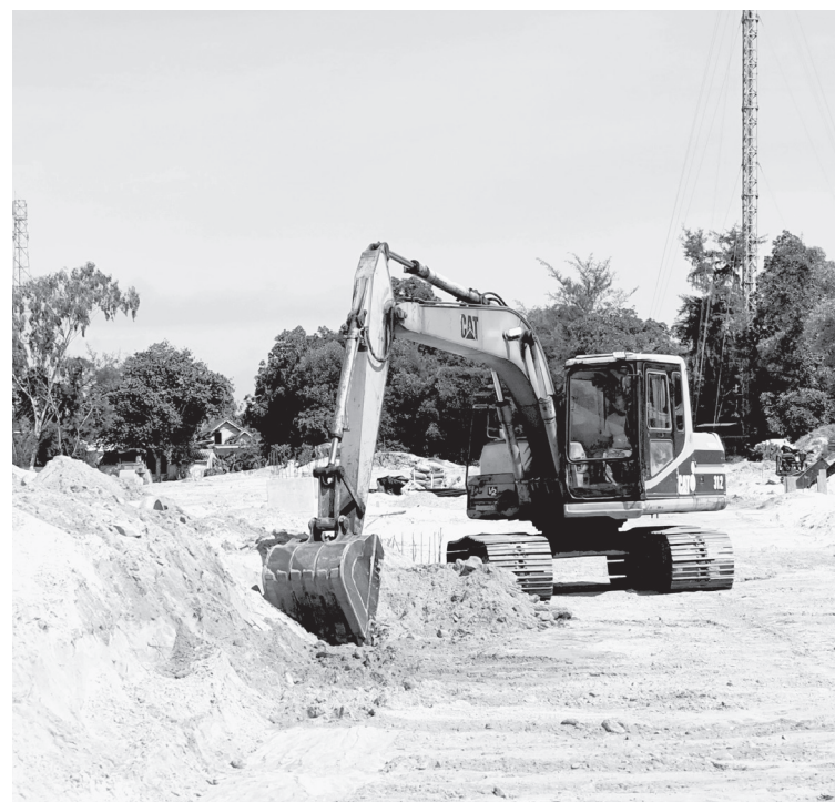
Khu tái định cư thuộc quy hoạch đô thị Dinh Mười, xã Quảng Ninh đang gấp rút thi công để hoàn thành các hạng mục -Ảnh: B.T
