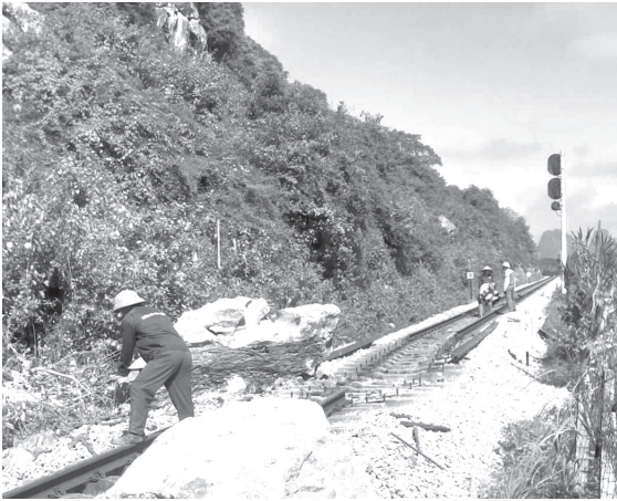
Hiện trường vụ đá rơi xuống đường sắt tại thôn Lạc Sơn
