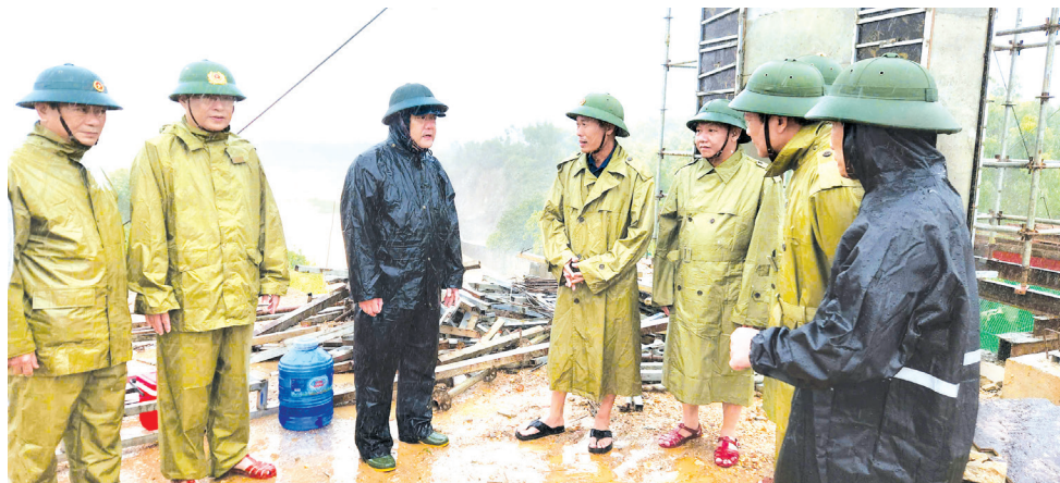
Chủ tịch UBND tỉnh Trần Phong kiểm tra công trình sửa chữa, nâng cấp hồ chứa nước Vực Tròn - Ảnh: T.Đ
