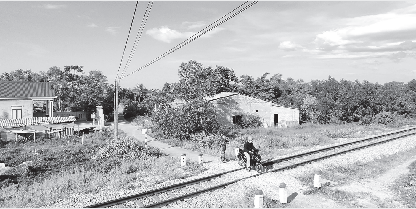
Lối tự mở qua đường sắt tiềm ẩn nguy cơ mất an toàn giao thông - Ảnh: T.P
